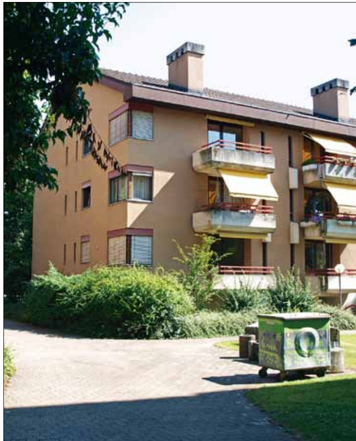
Baslerstrasse Allschwil: Erst durch den Blick in das Baugesuch erfuhren die Betroffenen das wirkliche Ausmass der geplanten Sanierung.
