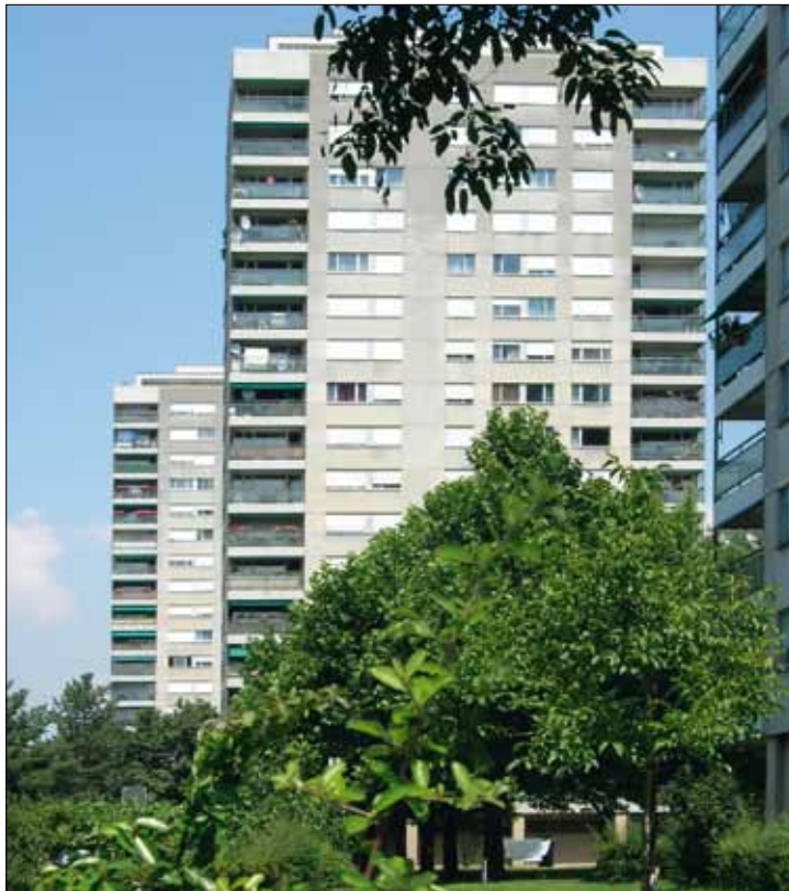
Die Stauseehochhäuser, hier noch vor ihrer Sanierung in den Jahren 2013 – 2016
