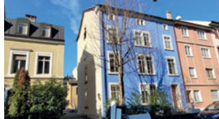
2 Pfeffingerstrasse 30-36 und Solothurnerstrasse 31 Frisina Architekten, Basel
