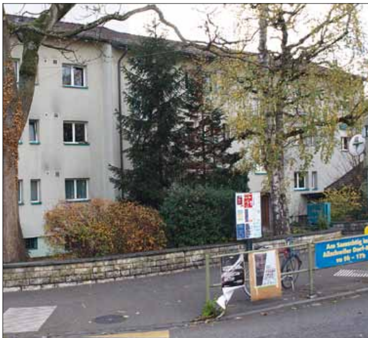
Diese Liegenschaft an der Baslerstrasse in Allschwil soll aufgrund eines Verkehrskreisels abgebrochen werden.
